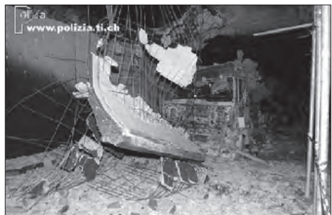
شکل ۱: خرابی وارده به سازه و وسایل نقلیه در تونل گوتارد بعد از آتش سوزی سال ۲۰۰۱
