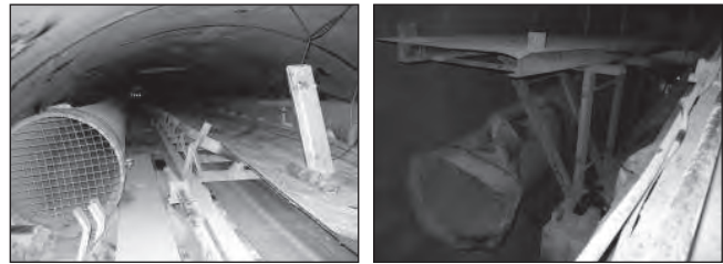
شکل ۷- سمت راست: نصب داکت تهویه در وضعیت نامناسب، با شدت جریان کم و نزدیک به دریچه مکش در سیستم تهویه مکشی - سمت چپ: نصب داکت سیستم تهویه مکشی در زیر سقف
