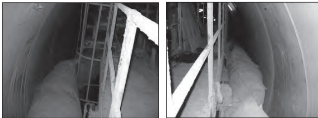
شکل ۶- پیچ و خم بیش از حد در مسیر داکت تهویه
