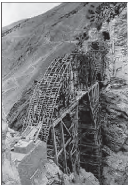
ساخت قالب قوسی پل ورسک
