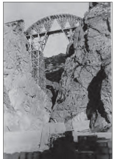
تکمیل داربست چوبی و قالب قوسی پل
