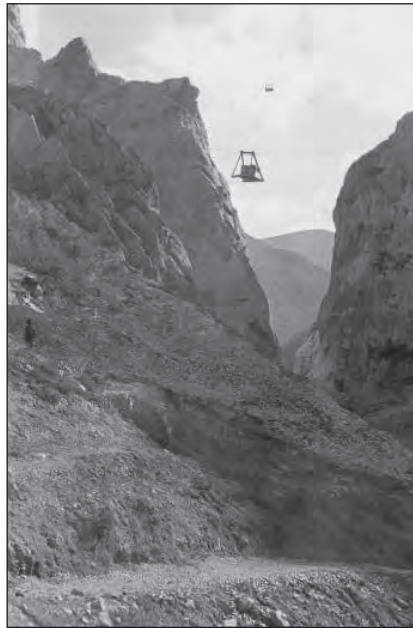
ارتباط کابلی میان دو سمت دره برای انتقال تجهیزات (پیش از ساخت پل ورسک)
