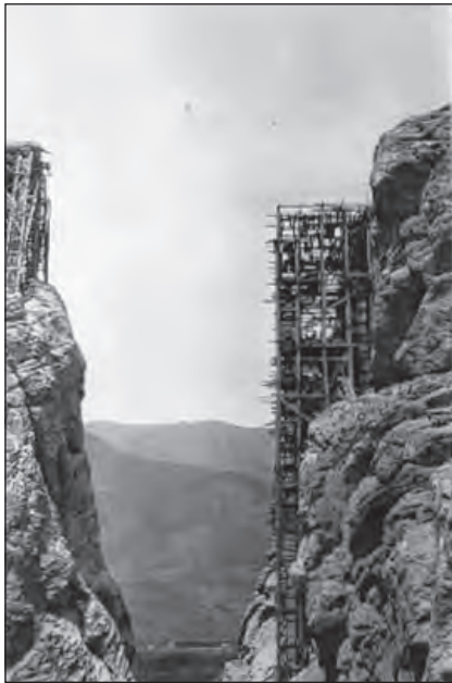
آغاز ساخت داربست چوبی زیر پل ورسک
