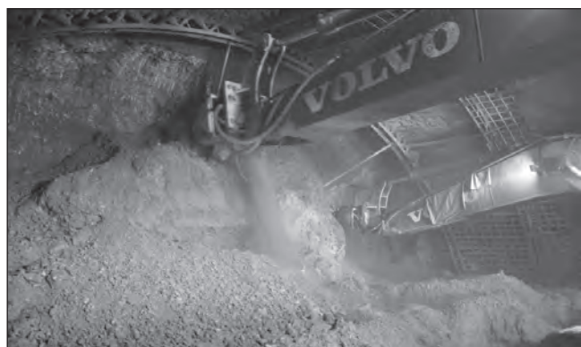
شکل ۱۵ استفاده همزمان از دو ماشین کله گاوی جهت حفاری بخش بالایی مقطع MII
