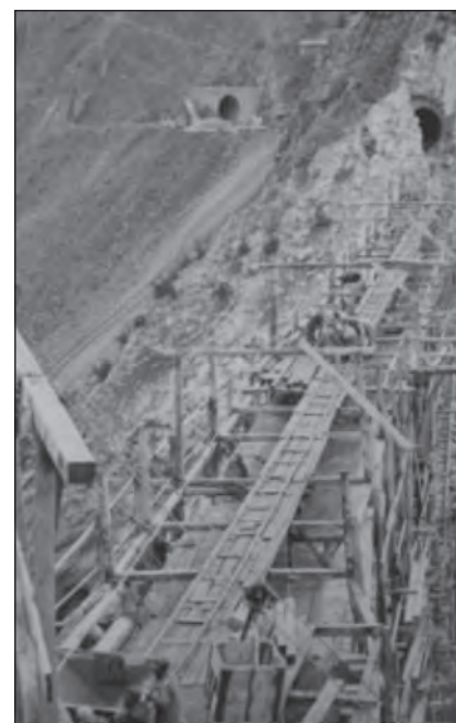
تکمیل سطح پل ورسک بر روی قالب قوسی
