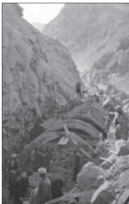
ساخت تونلی به روش کند و پوش در بخش شمالی
