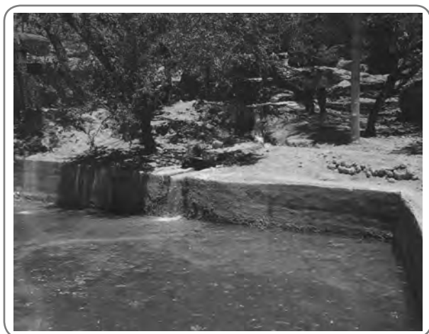
شکل ۵. نمای مظهر قنات غیاث آباد پشت کوه
