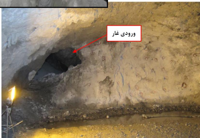
برخورد با غار کارستی در تونل
