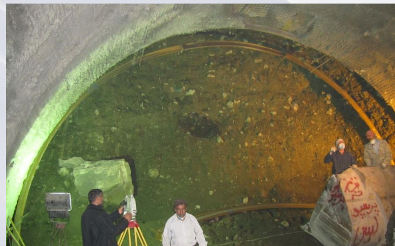
تسريع در اجرای تحکيمات زون های سست
