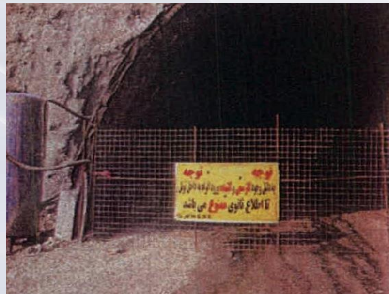
• برخورد با پدیده گاز در تونل حفاری شده در دامنه دماوند
