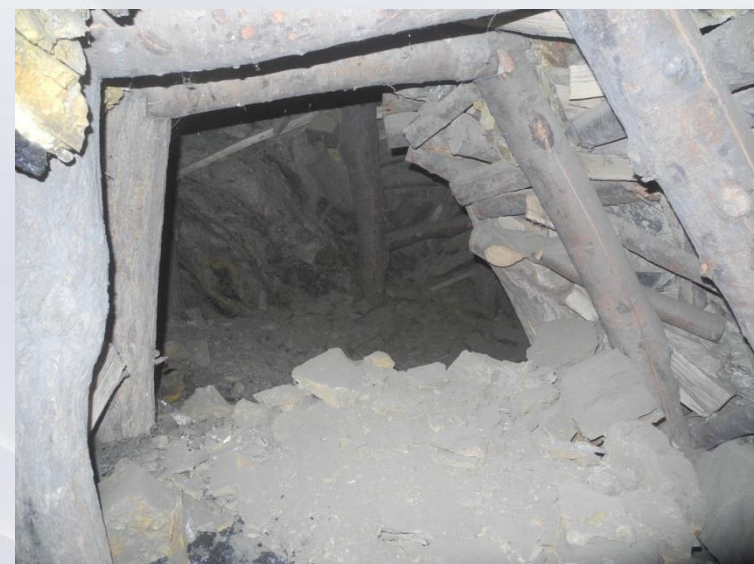
برخورد با معدن متروکه در سقف تونل
