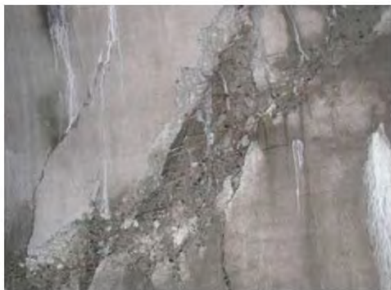
شکل (۵): نمونه‌ای از آسیب لاینینگ در اثر رخداد زلزله و حرکت گسل شکل (۶): نمونه‌ای از آسیب لاینینگ در اثر رخداد زلزله و حرکت گسل
