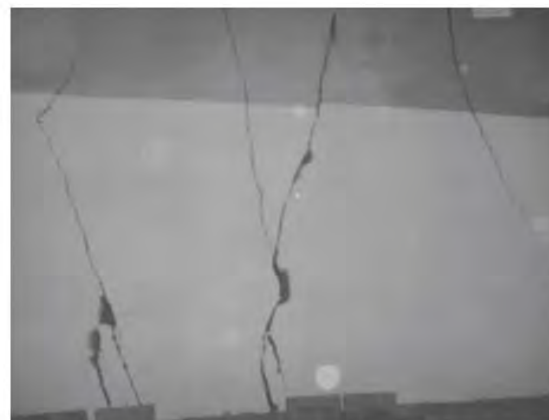
شکل (۵): نمونه‌ای از آسیب لاینینگ در اثر رخداد زلزله و حرکت گسل شکل (۶): نمونه‌ای از آسیب لاینینگ در اثر رخداد زلزله و حرکت گسل
