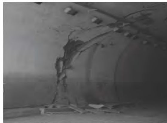
شکل (۳): نمونه‌ای از آسیب لاینینگ در اثر رخداد زلزله و حرکت گسل شکل (۴): نمونه‌ای از آسیب لاینینگ در اثر رخداد زلزله و حرکت گسل
