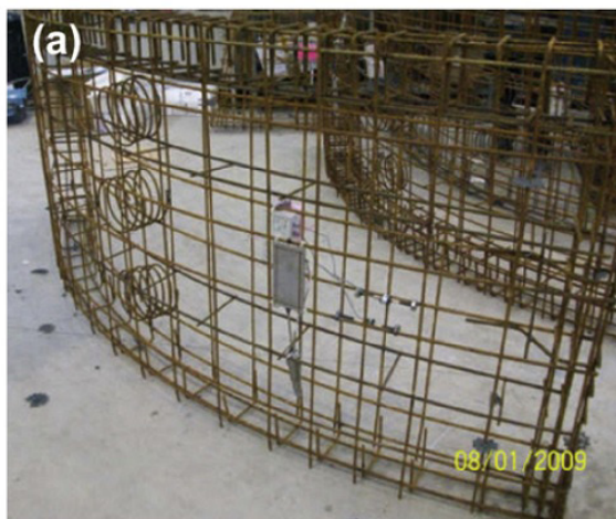
شکل ۱۰- قفس های تسلیح برای سگمنت های پیش ساخته: (a) PS-۵۰، (b) طرح
