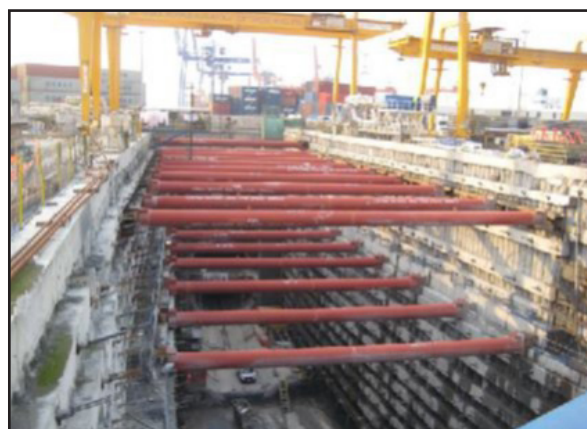
شکل ۴- اجرای تونل به روش کند و پوش در بخش آسیایی
