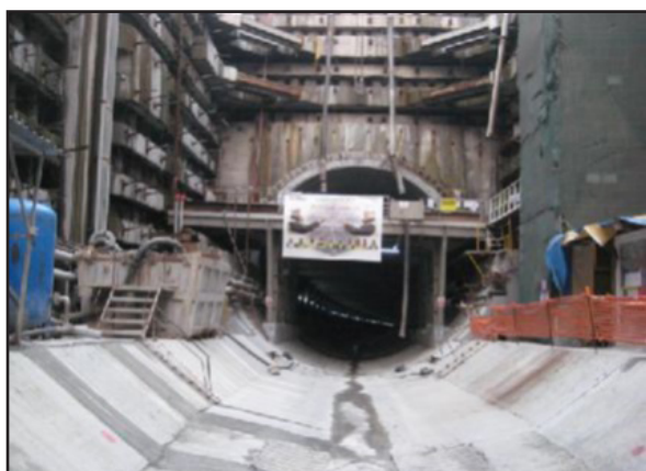
شکل ۷- محل اتصال کند و پوش و TBM در بخش آسیایی
