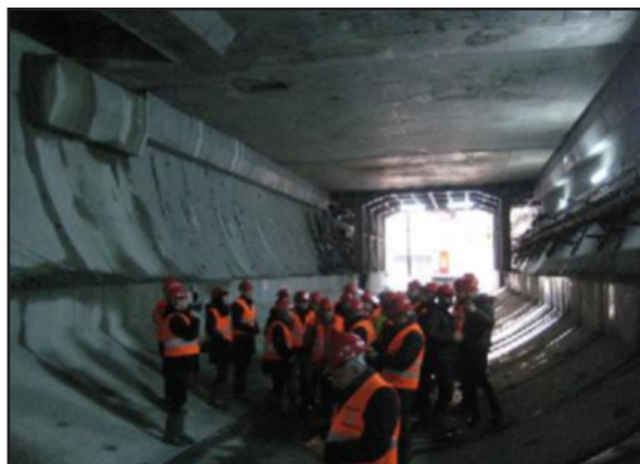
شکل ۶- تکمیل دك بالای تونل و شروع دك پایین
