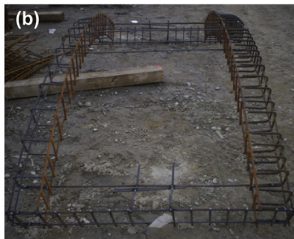
شکل ۱۰- قفس های تسلیح برای سگمنت های پیش ساخته: (a) PS-۵۰، (b) طرح
