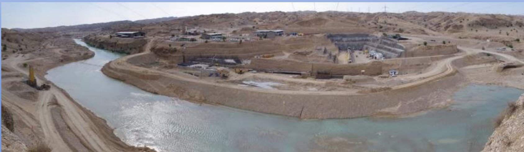
تصویر پانوراما از محدوده اجرایی کارگاه شامل پرتال ورودی تونل، فرازبند - نشیب بند شماره ۲، کانال انحراف شماره ۲، جناح چپ سد و آبگیر (آبان ۹۳)
