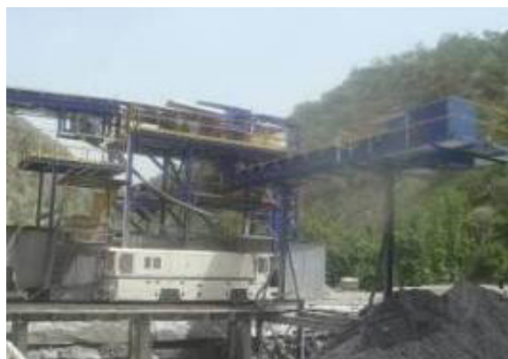
شکل (۵): ترابری نوار نقاله در بیرون تونل در پروژه زاگرس
