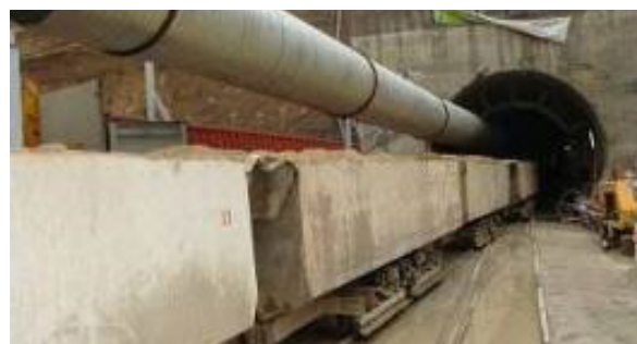
شکل (۱): سیستم ترابری ریلی استفاده شده در پروژه تونل بلند زاگرس
