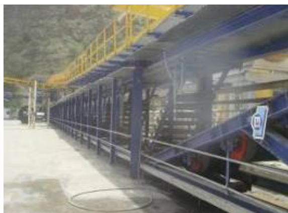
شکل (۴): مخزن نوار نصب شده در پروژه تونل زاگرس
