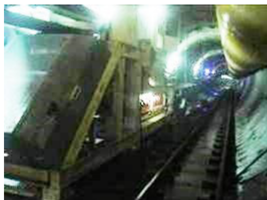
شکل (۶): نمونه‌ای از تقویت‌کننده (بوستر) میانی نوار در پروژه تونل بلند زاگرس
