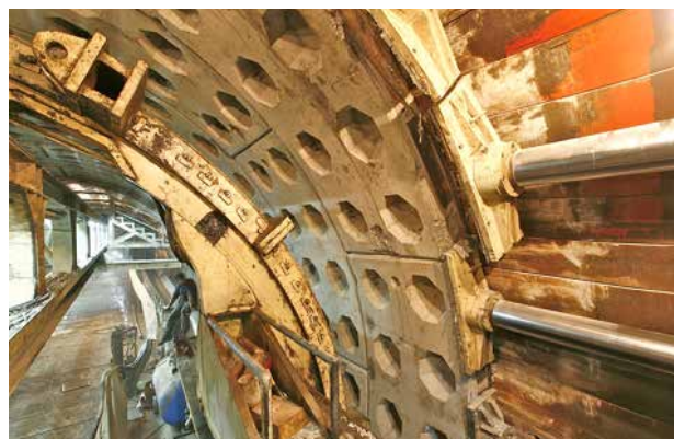
شکل ۱۱- حرکت شیلد به سمت جلو با استفاده از فشار جک‌ها به آخرین رینگ سگمنت نصب شده
