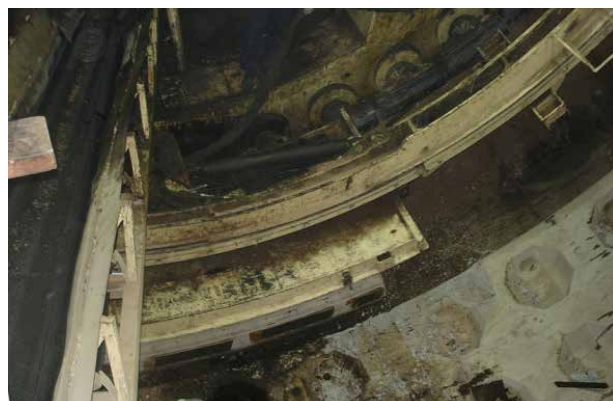
شکل ۱۳- ارکتور در حال بلند کردن قطعه پیش ساخته بتنی
