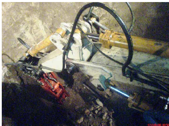
شکل ۷- چکش هیدرولیکی نصب شده بر روی بازوی دو منظوره طراحی و ساخته شده جهت حفاری در سنگ و ادامه مسیر
