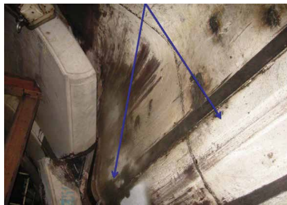
شکل ۱- تغییر شکل ایجاد شده در سپر TBM پروژه Gilgel Gibe
