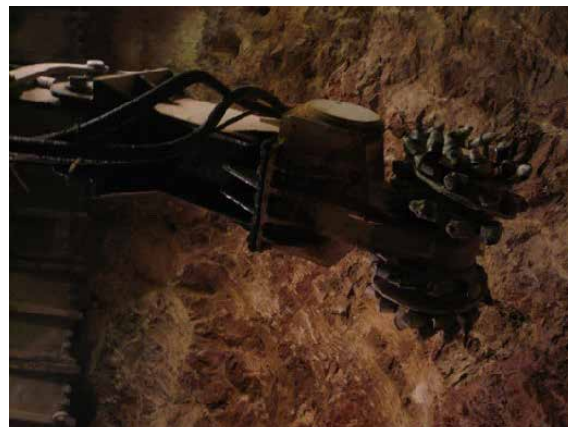
شکل ۸- درام کاتر نصب شده بر روی بازوی دستگاه حفار زوکور جهت حفاری در سنگ و ادامه مسیر
