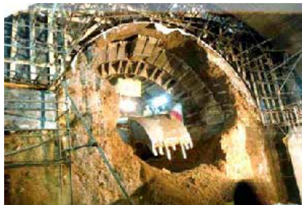
شکل ۲- سیستم حفاری با بیل در دستگاه حفاری زوکور بکار رفته در عملیات حفاری خطوط (۱) و (۲) متروی تهران
