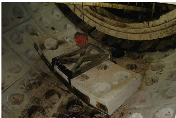
شکل ۱۴- وینچ در حال انتقال سگمنت به زیر صفحه ارکتور
