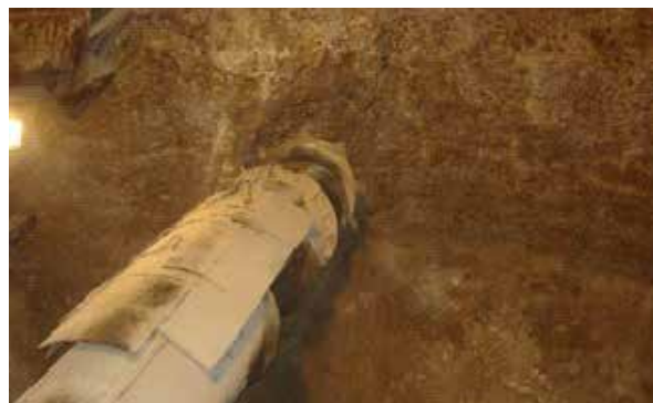
شکل ۳- سیستم حفاری با رودهدر مخروطی در دستگاه حفاری زوکور؛ بکار رفته در عملیات حفاری خط ۴ متروی تهران
