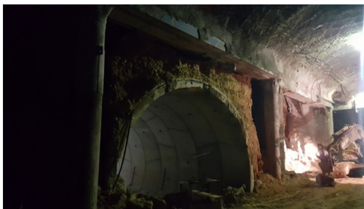
شکل ۱۳- اجرای راد خود حفار در تراز فوقانی تونل موجود
