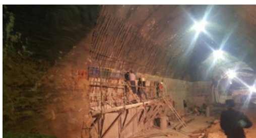
حفاری بنج و اجرای بخشی از سازه اصلی EXC5
