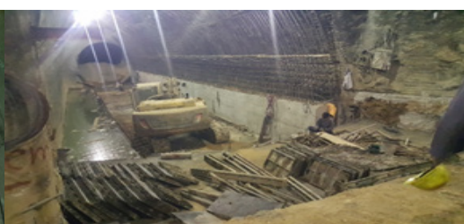
اجرای بخشی از سازه نهایی در EXC3
