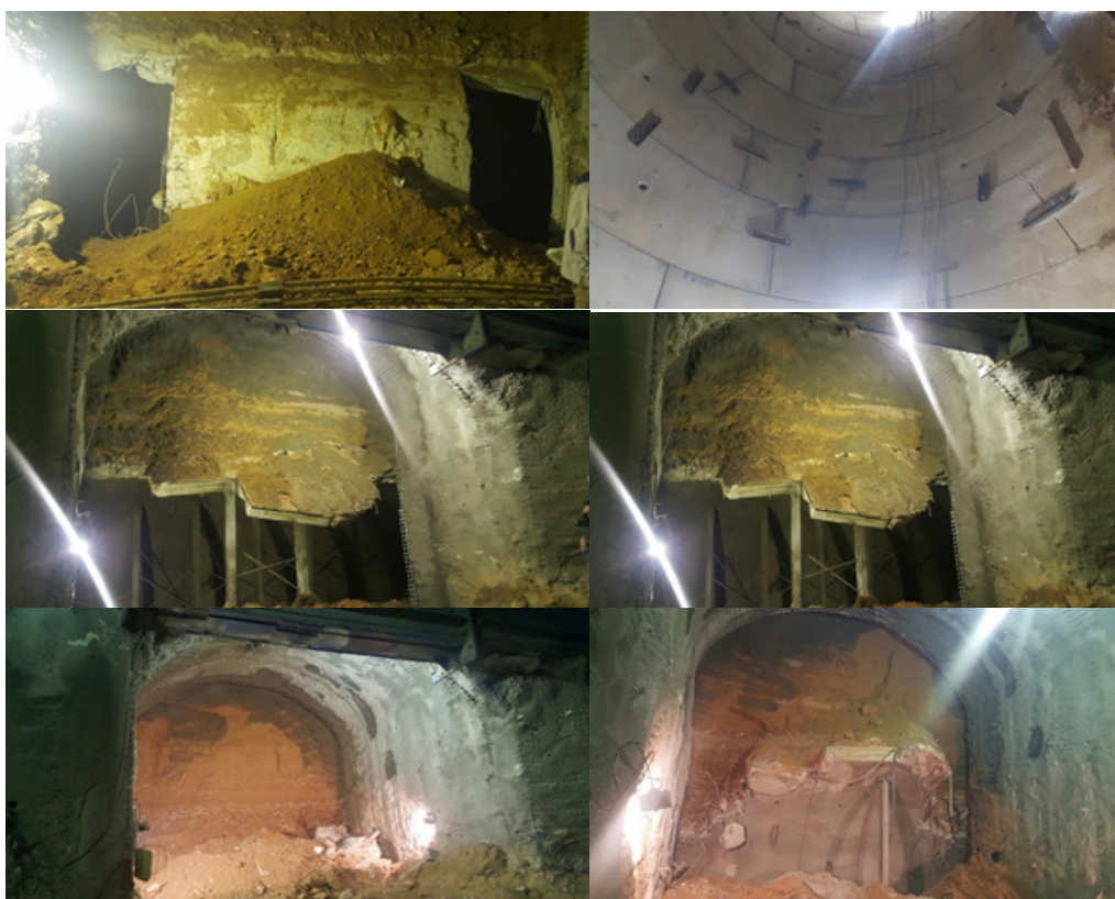
شکل ۱۱ - مراحل اجرای پارت B و تخریب تونل موجود
