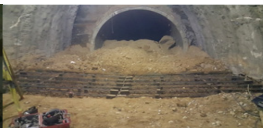
اجرای کف بند موقت تاپ
