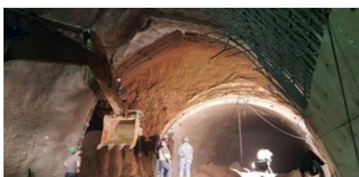
حفاری تاپ و اجرای کف بند موقت در محدوده پارت EXC5 ( E )
