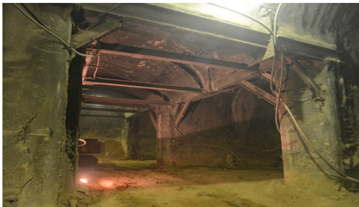
شکل ۱۲- محدوده پارت B با اجرای کلیه سه راهی ها
