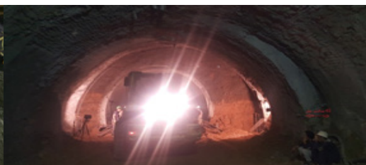
حفاری تاپ و اجرای کف بند موقت در محدوده پارت EXC7 ( G )
