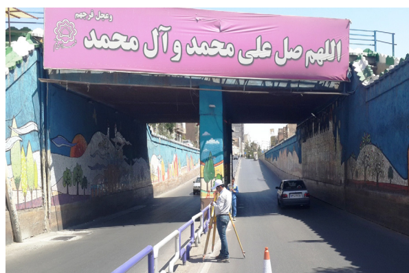
شکل ۱۱- عملیات نشست سنجی در محدوده پل راه آهن
