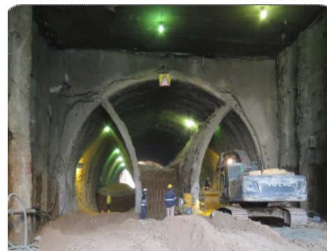
شکل ۱۴: برخی تصاویر مراحل اجرای بخش تونلی پروژه
