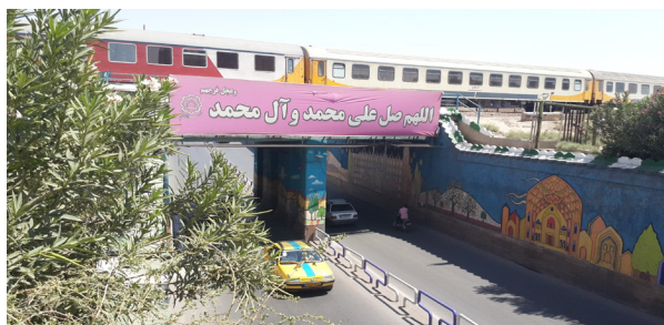
شکل ۴- عبور قطار از روی پل در لحظه حفاری تونل در زیرزمین
