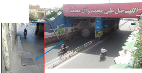
شکل ۶- چاه پر شده با بتن پلاستیک در زیر پل
