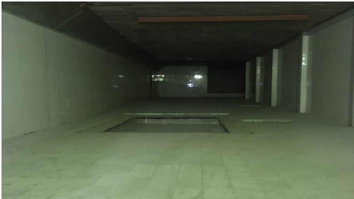
( اتاق هواکش متروی خط هفت بدون تجهیزات )
