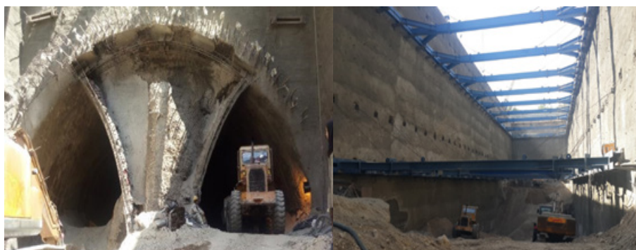
شکل ۳- ساخت ایستگاه در خط ۶ متروی تهران: (الف) روش کند و پوش و (ب) روش NATM.
