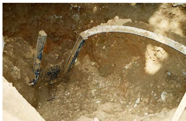
شکل ۱۱- سیستم قابهای نگهدارنده و پل‌ها بعد از ریزش به سمت پله سمت راست منحرف شده‌اند
